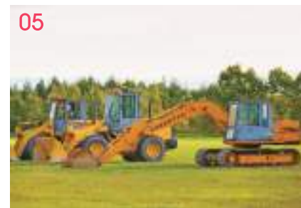
05 建設系車両実習場 建設系車両の資格取得に向けてトレーニングを行う。
